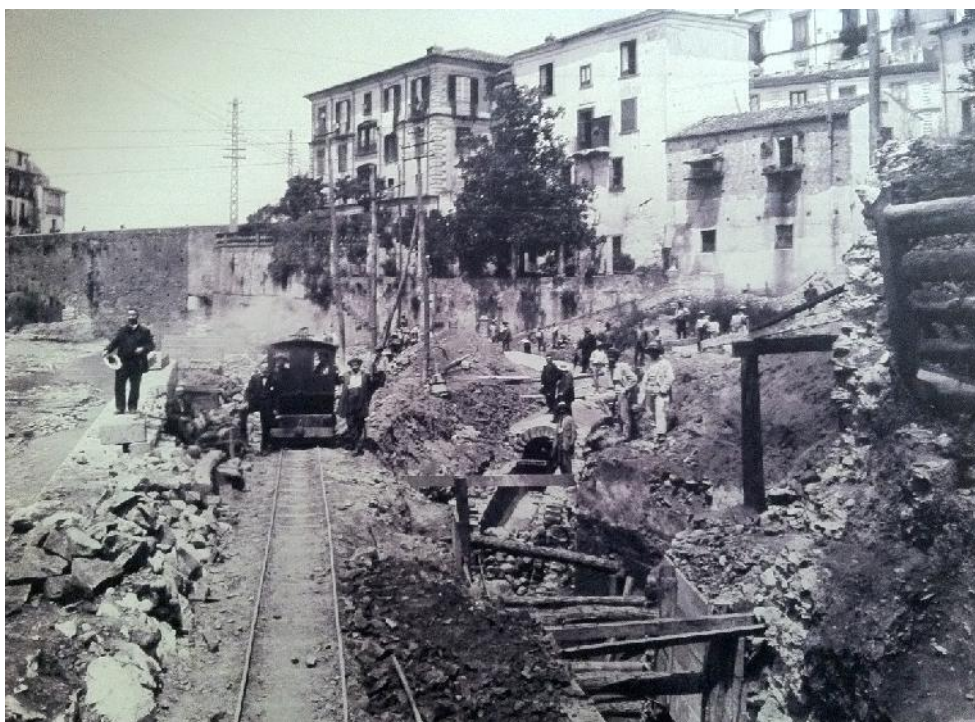
Figura 11 Inalveamento del Crati e del Busento e costruzione del collettore ripuario delle fogne a destra del Crati, a monte del ponte S. Francesco a cura dell' Ing. Vocaturo (collezione Dott. R. Bilotti).
