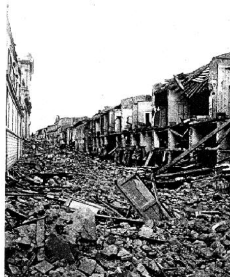
Figura 20 Facciate di edifici di Messina dopo il terremoto del 1908 (Giuffrè, 1993)
