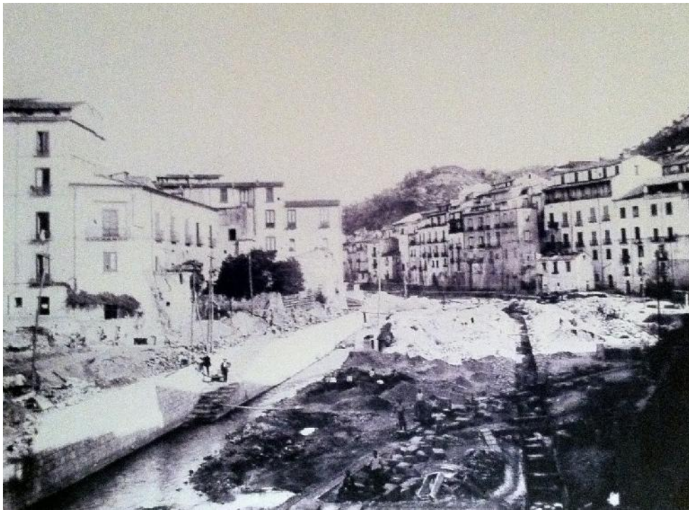
Figura 10 Inalveamento del Crati e del Busento e costruzione del collettore ripuario delle fogne a destra del Crati, a monte del ponte S. Francesco a cura dell' Ing. Vocaturo (collezione Dott. R. Bilotti).
