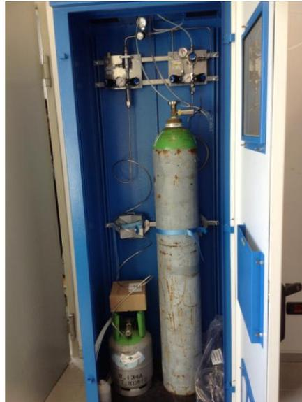
**Figura 3.4.** Armadio di sicurezza completo di bombole e rampe di riduzione
