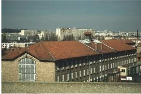
Vista esterne dell'Istituto penitenziario
