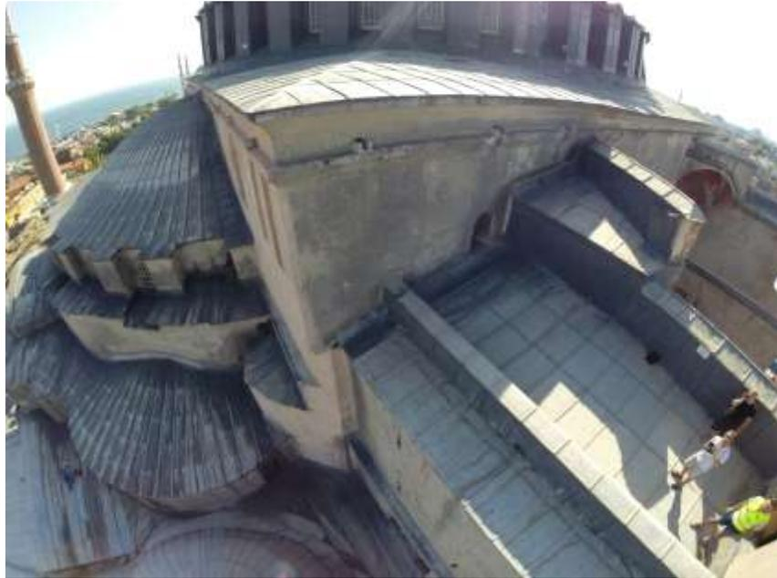
Fig. 4.5 Fotografia da drone che evidenzia punti di giunzione della struttura non presenti nelle tavole di Van Nice.
