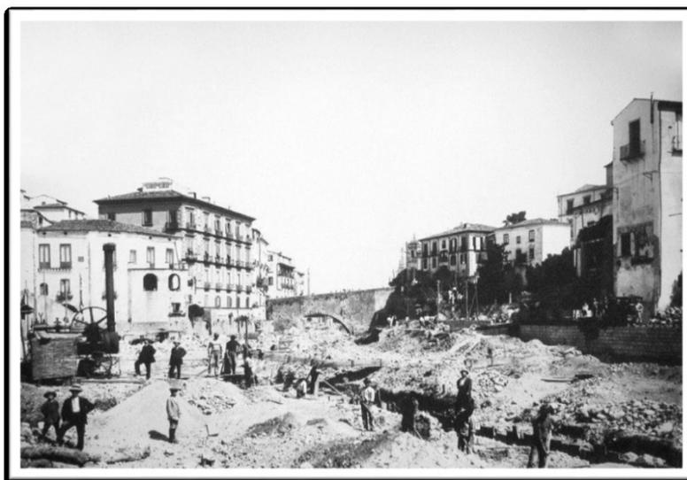
*Figura 3-8. Cosenza, 1912. Lavori di inalveamento del Crati e del Busento e collettori ripuari delle fognature di Cosenza. (Fotografo R. Gaudio, Archivio Bilotti, Casa delle Culture, Cosenza – 2012).*
