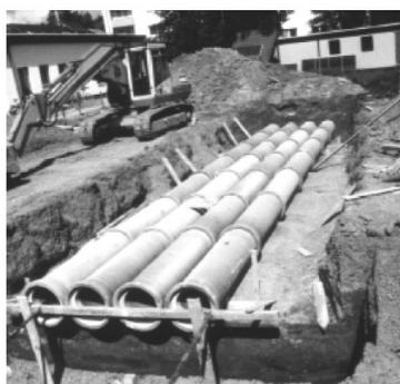
Fig. 1.4 – Esempio di applicazione degli EAHEs presso l'Università di Marburg (D)
