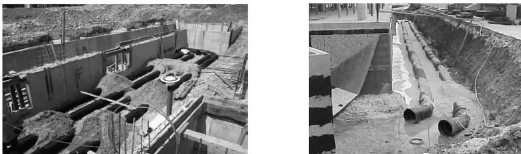
Fig. 1.5 – Esempi di applicazione degli EAHEs presso il Fraunhofer ISE di Friburgo (D) e presso Lamparter (D)
