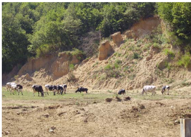
Figura 3.15 – Fenomeni franosi superficiali a cui sono associati processi dovuti alle acque di ruscellamento lungo una scarpata di origine antropica.
