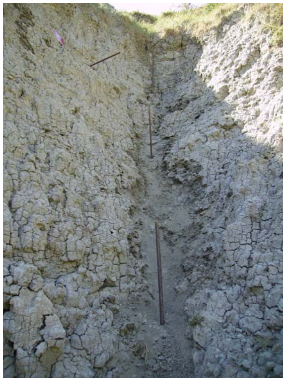
Figura 4.8 – Parte medio-alta del calanco monitorato nel quale si possono osservare sia i paletti lungo il canale che sui versanti.
