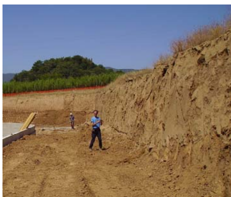
Figura 2.19 – Depositi colluviali lungo uno scavo nella parte basale di un versante in località Pianette, sponda sinistra del torrente Turbolo.
