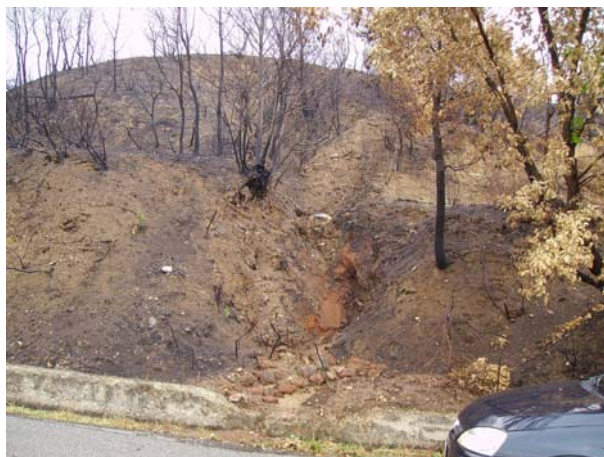
Figura 2.29 –Area percorsa da un incendio nell’agosto del 2007 dove con le prime piogge autunnali è stata interessata da processi di erosione idrica superficiale sia di tipo laminare che di tipo incanalata.
