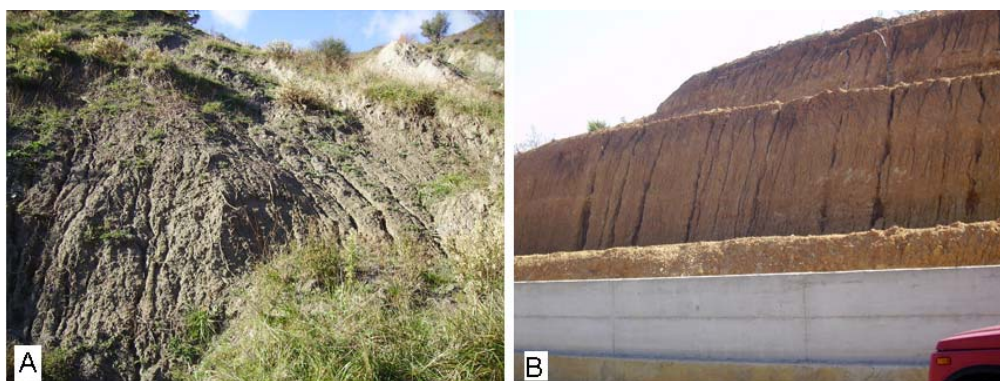
Figura 3.7 – A) Fenomeni di rill erosion che interessano su un corpo di frana su argille; B) solchi ( rill ) di erosione che interessano una scarpata terrazzata su conglomerati-sabbiosi lungo la strada che collega gli abitati di Sartano e Torano castello.
