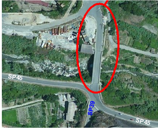
Figure 4.18: Fiume di Mare Bridge: aerial photo
