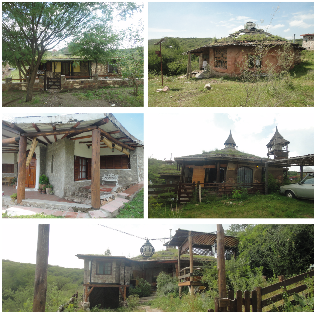
Fig. 10: Costruzioni in paglia e argilla nell'Ecobarrio Villa Sol, Salsipuedes, Prov. di Cordoba (Argentina).
