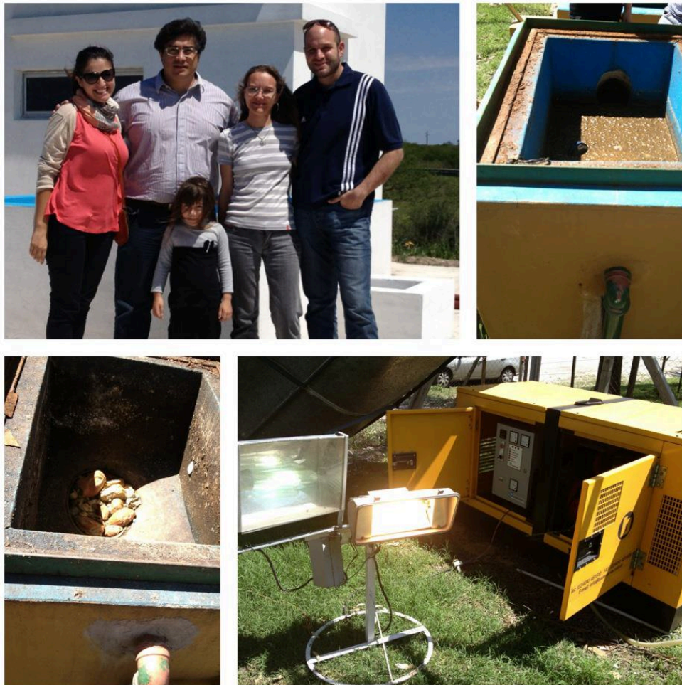
Fig. 9: Produzione di energia elettrica a partire dal processo di biodigestione dei rifiuti urbani: villaggio rurale argentino, Cerrito, provincia di Entre Rios.
